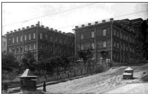
Рис. 8. Общий вид Восточного института. Владивосток
